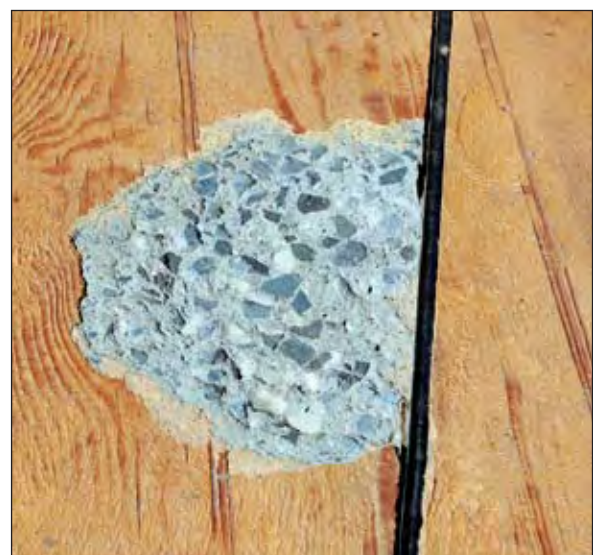
Figure 6.10 Edge spalling
